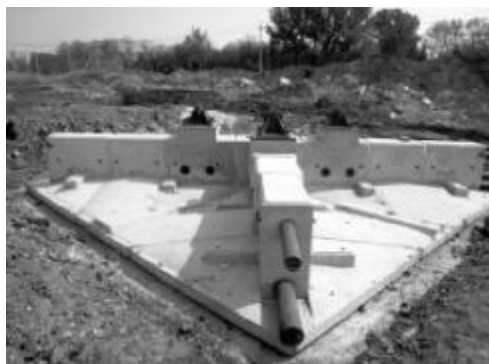
图1 预制拼装式基础
